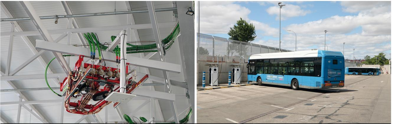
**links:** Detailansicht des Lade-Pantografen mit der entsprechenden Sprinklerleitung **rechts:** Im Außenbereich stehen Ladesäulen für die Busse zur Verfügung. Hier gibt es keinen Sprinklerschutz.
