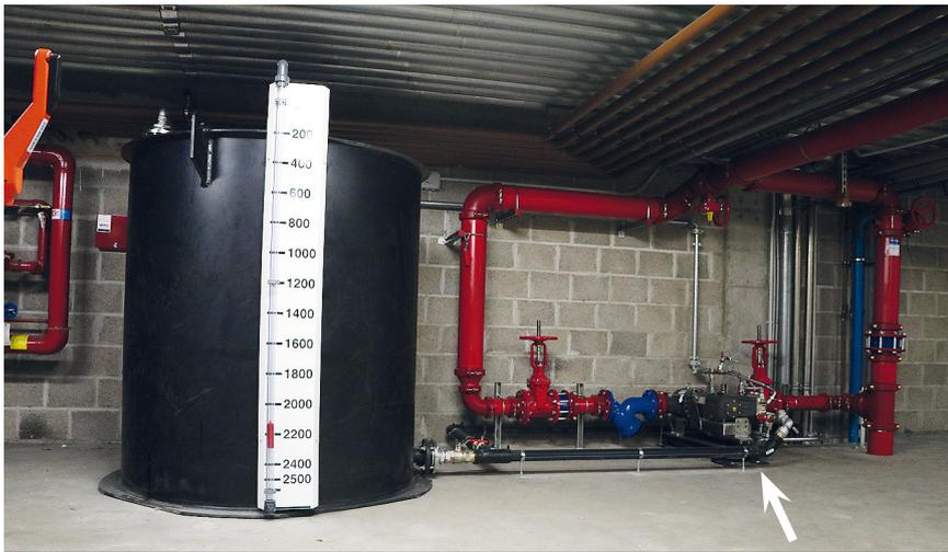
In der Sprinklerzentrale des Busdepots sind der F-500-Vorratstank sowie der Zumischer (Pfeil) eingebaut und in die bestehende Sprinkleranlage integriert worden.
