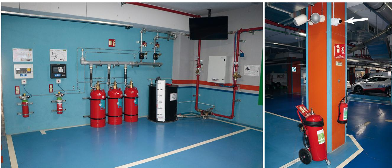
**links:** Die Stand-alone-F-500-Sprinkleranlage zum Schutz der Elektroladepplätze in einer Tiefgarage ist sehr kompakt aufgebaut und benötigt nur einen halben Pkw-Stellplatz. **rechts:** Die spezielle Wärmebildkamera (Pfeil) kann Flammen und Wärmequellen in einer Entfernung von bis zu 40 Metern detektieren.
