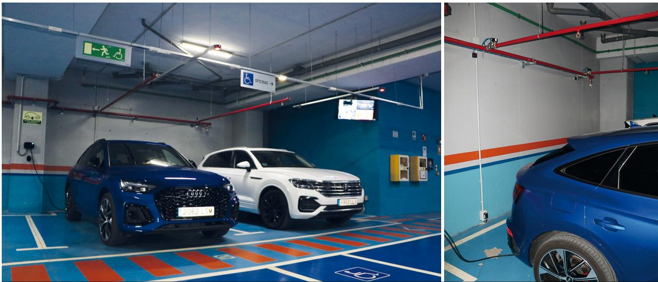
**links:** F-500-Sprinkleranlage für Ladepplätze von Elektrofahrzeugen in einer Tiefgarage. Die Anlage wurde in der Tiefgarage der Errichtfirma Iberext realisiert. **rechts:** An der Wand sieht man unten die Wärmebildkamera zur Überwachung der Hochvoltbatterie und über dem Pkw die Sprinklerköpfe.
