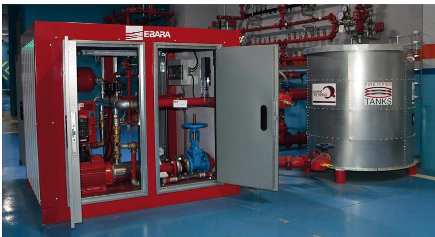
Die gesamte Pumpen- und Zumischtechnik einer Stand-alone-F-500-Sprinkleranlage (ohne den Löschmittelzutank) kann auch in einem Zehn-Fuß-Container montiert werden.
